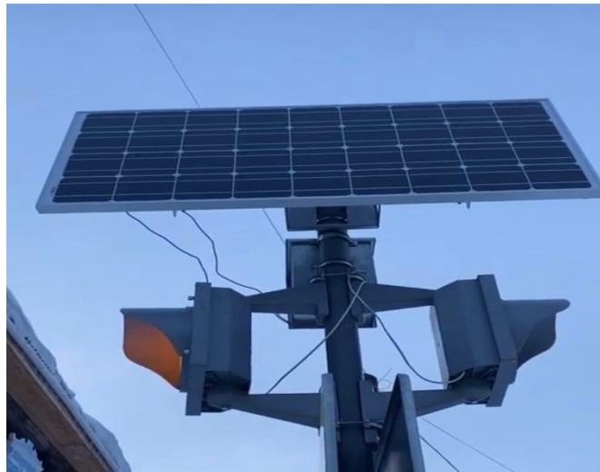
Рисунок 1 - Использование фотоэлектрической станции в нерегулируемых пешеходных переходах [3]
